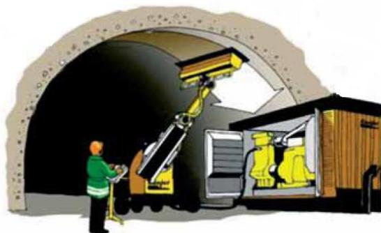
**Figura 16.** Eliminación de hormigón dañado por hidrodemolición.
