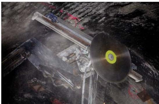
**Foto 3.** Sierra radial realizando un corte transversal en la clave.
